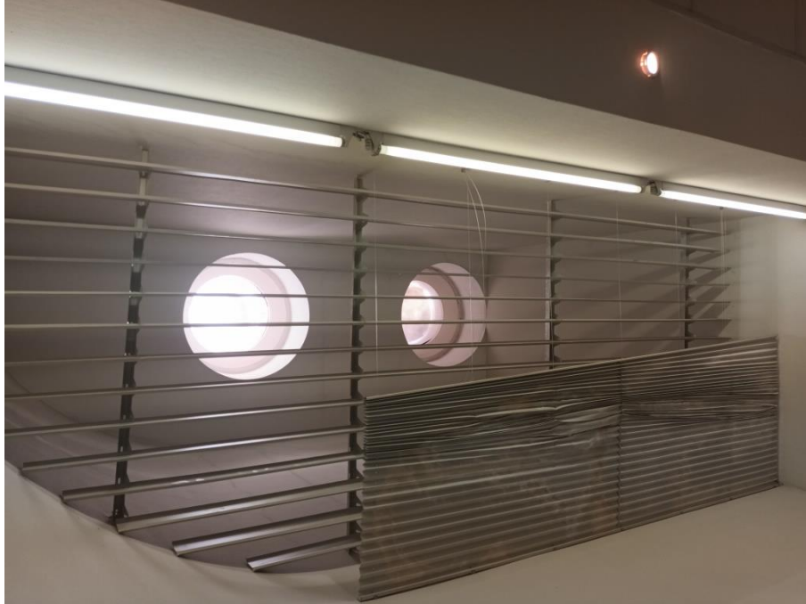
Vista del lucernario existente
