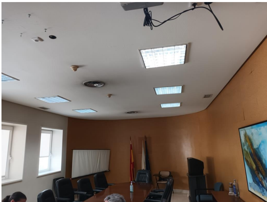
Vista actual de la sala de juntas
