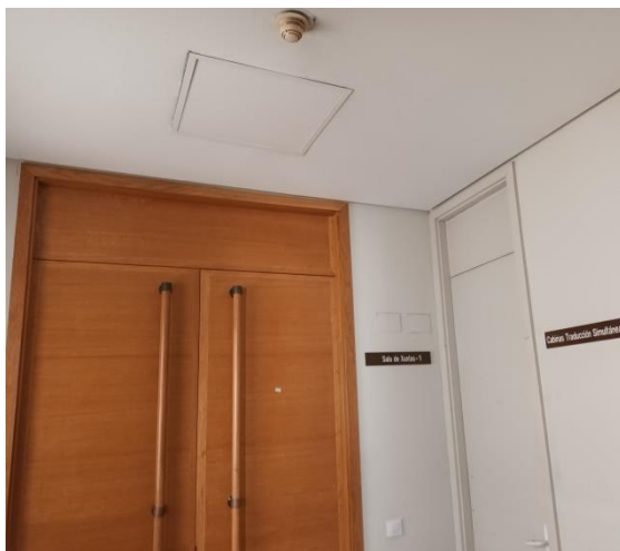
Foto 1, puerta y tabique a retirar
